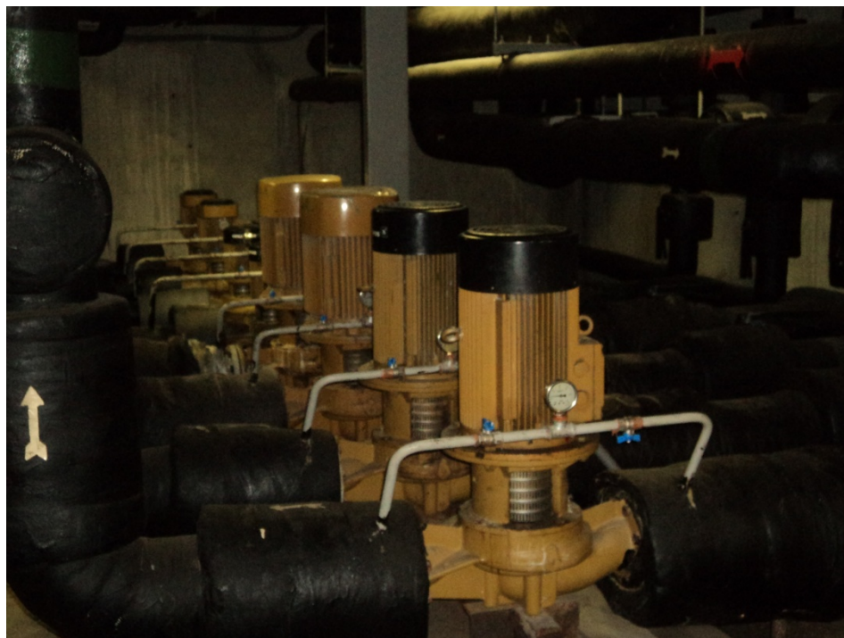
Ilustración 7: Bombas de circulación
