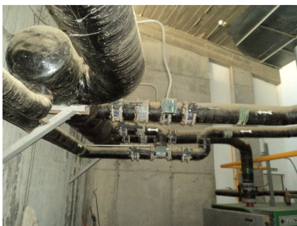
Ilustración 4: Detalle del aislamiento de las tuberías a la salida de la sala de calderas
