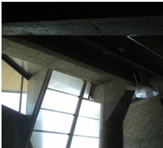
Ilustración 10: Unión entre cubierta y cerramientos del edificio
