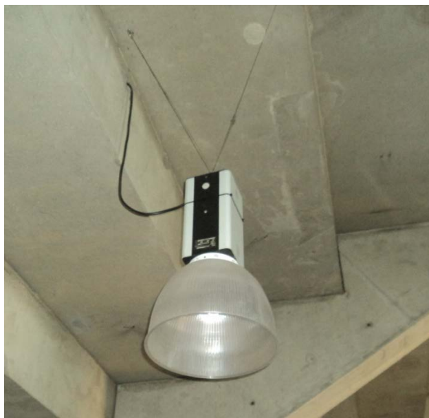
Ilustración 11: Detalle de las luminarias de vapor de mercurio
