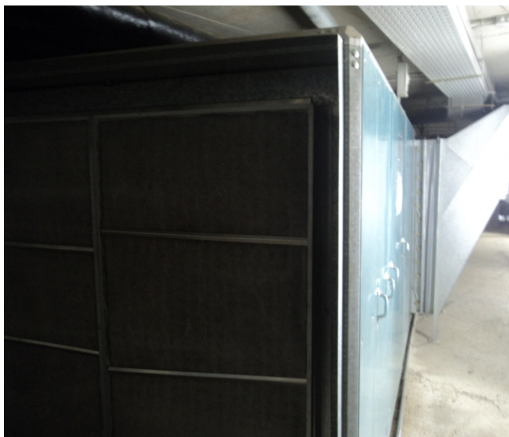
Ilustración 9: Climatizadoras grandes bajo gradas
